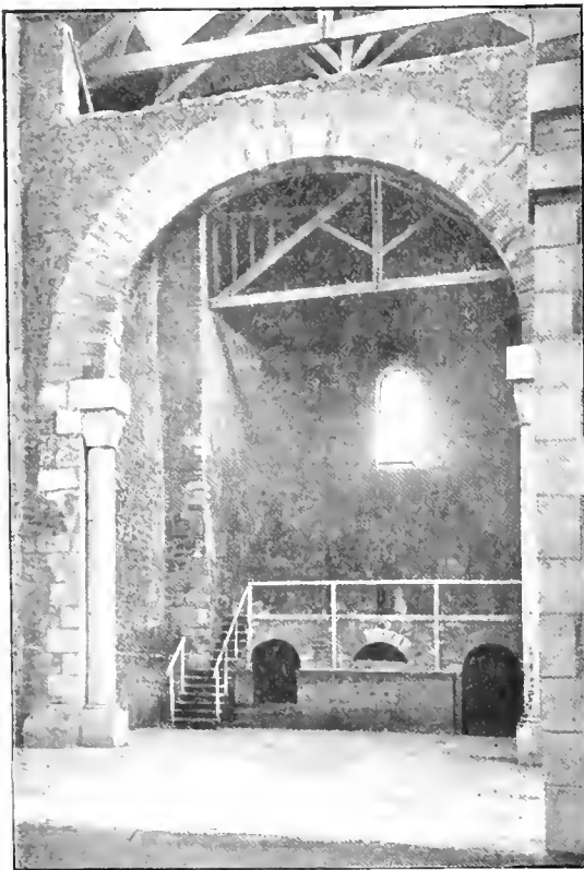
Église de Saint-Philibert de Grandlieu — Vue intérieure.
